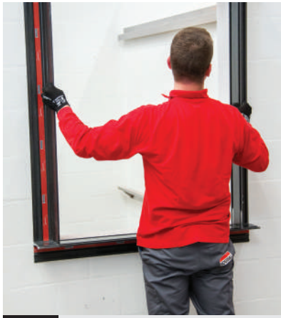
09 Coloque el marco contra la pared y presione firmemente mientras se mueve arriba y abajo, de izquierda a derecha
