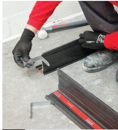
03 Coloque las uniones angulares
