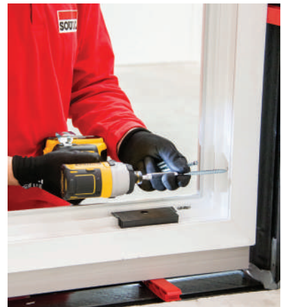
14 Fije la ventana mecánicamente
