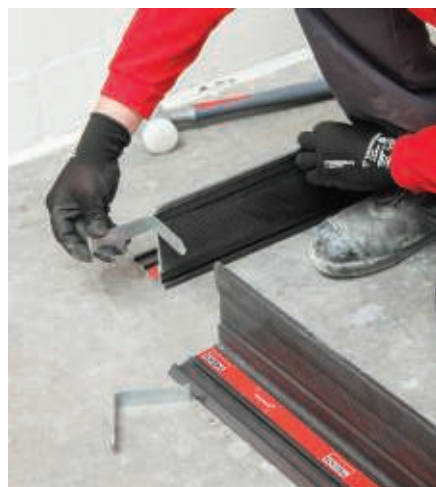
03 Coloque las uniones angulares
