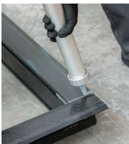
07 Coloque la cola en todas las uniones
