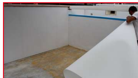
Construcción de piscinas
