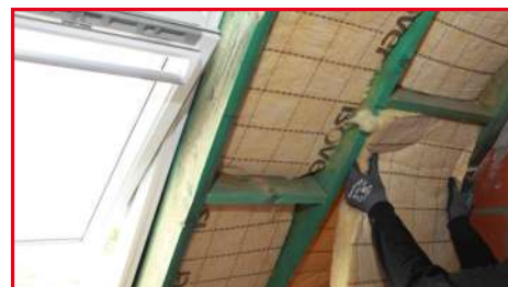
Acabado del techo: interior
